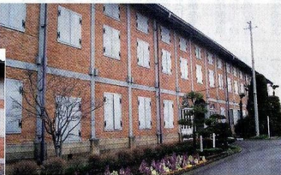
工場の正面にある東側倉庫は長さ104.4m、幅12m、高さ14m。木骨レンガ造りで、切妻造り2階建ての棧瓦葺。中庭に通じるレンガ積みアーチには「明治5年」と刻印されている。反対側には平面形、構造とも東棟と同じの西棟がある
